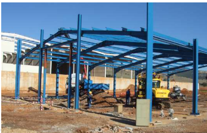
* Construcción de una nave industrial en Puertollano (Ciudad Real)
